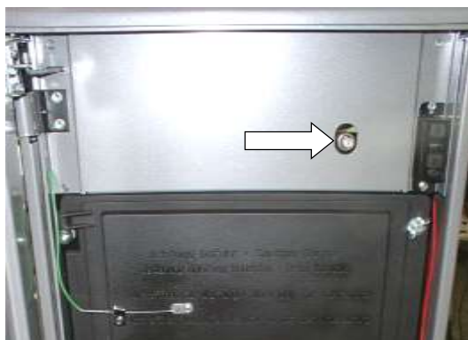
Fig. 45 : position de la soupape de purge d'air
