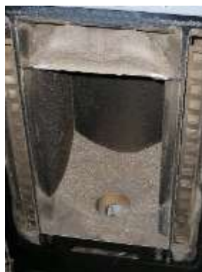
Fig. 111 : salissure normale (cendres volantes sèches)
