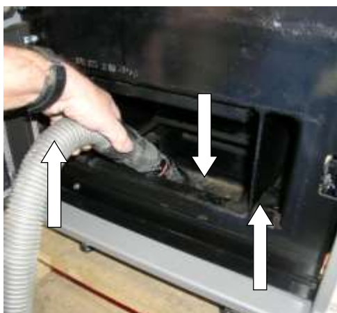
Fig. 139 : aspiration de l'accumulateur des gaz de combustion et des tirages des gaz de combustion
