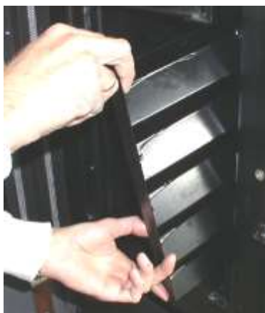
Fig. 135 : retrait du turbulateur
