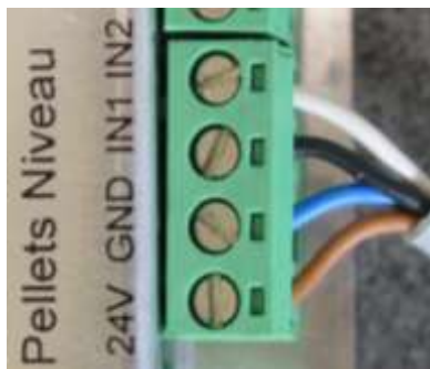
Fig. 65 : raccordement électrique niveau de pellets
