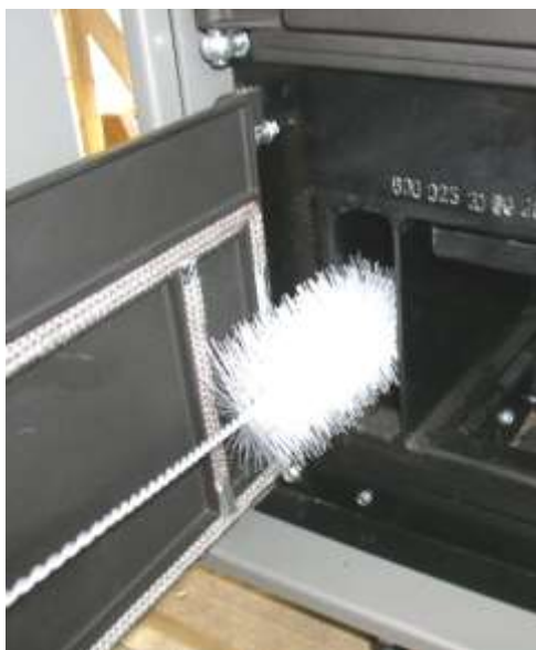
Fig. 138 : nettoyage des tirages de gaz de combustion bas
