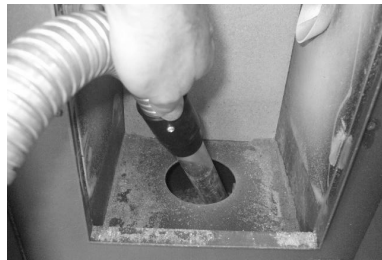
Fig. 39 - Nettoyage l'espace du brasero
