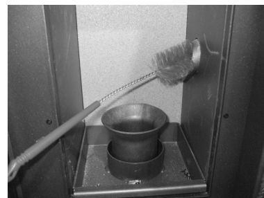
Fig. 40 - Nettoyage avec nettoie-pipes
