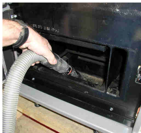
Fig. 109 : aspiration de l'accumulateur des gaz de combustion
