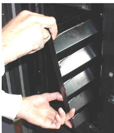
Fig. 135 : retrait du turbulateur
