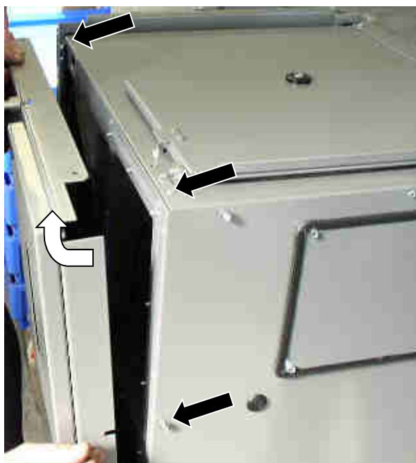
Fig. 13 : démontage habillage latéral
