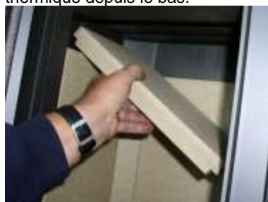
Fig. 38 : démontage du déflecteur
