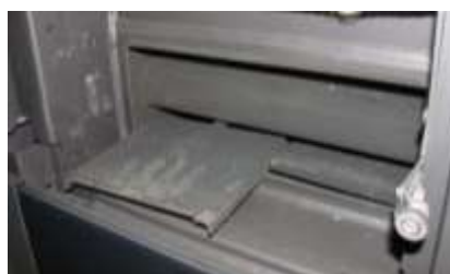
Fig. 36 : retrait des déflecteurs en acier
