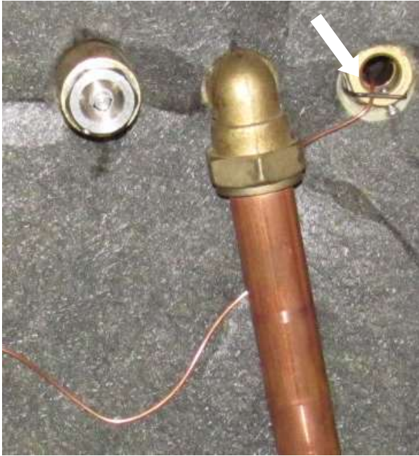
Fig. 22 : douille immergée du capteur
