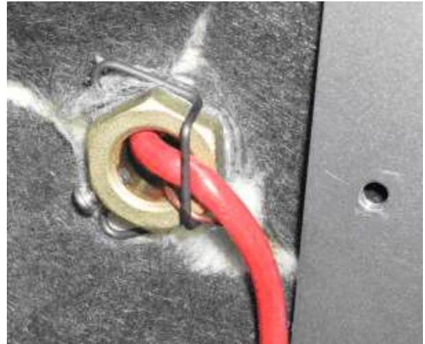
Fig. 24 : étrier de retenue capteur chaudière
