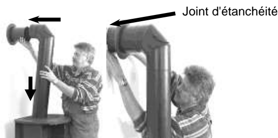
Fig. 5 : montage du tuyau de fumée
