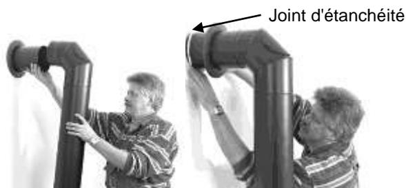
**Fig. 24 : raccordement du tuyau de fumée à la cheminée**
