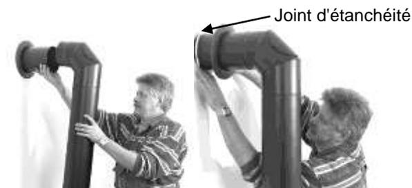
**Fig. 21 : raccordement du tuyau de fumée à la cheminée**
