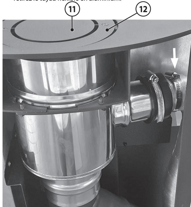
Le collier de serrage desserré sera par la suite utilisé pour fixer le tuyau flexible en aluminium à la buse de raccordement montée.
