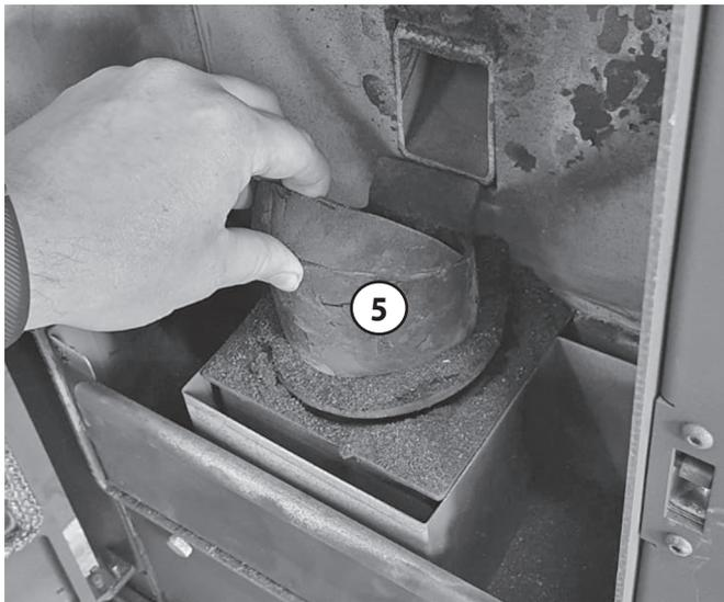
Après nettoyage, il ne doit plus rester de résidus de cendres dans le pot brûleur. Les résidus brûlés et incrustés doivent être également éliminés le mieux possible. Les trous du pot brûleur ne doivent pas être obturés ou bouchés.
